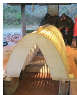
Gabarit en place
